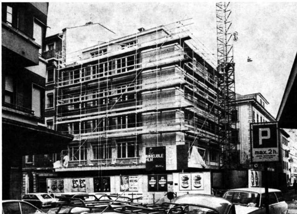
Immeuble locatif rue de la Mairie 7 - rue Henri-Blanvalet
