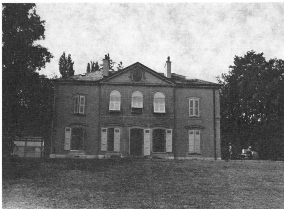
Restauration et transformation villa « Le Chêne », parc du Conservatoire botanique — état après les travaux.
