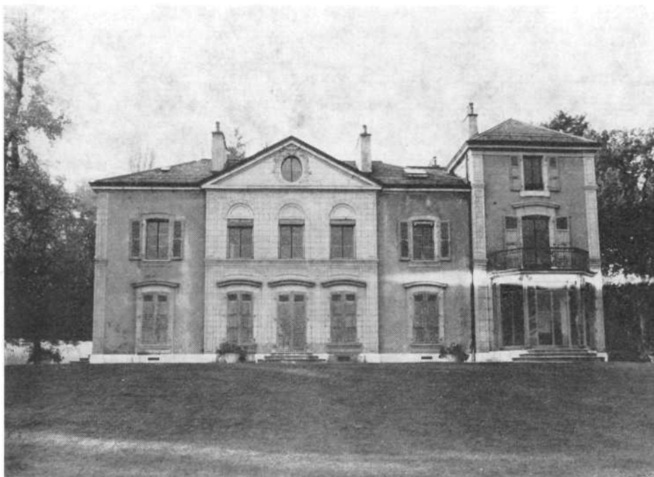
Restauration et transformation villa « Le Chêne », parc du Conservatoire botanique — état avant les travaux.
