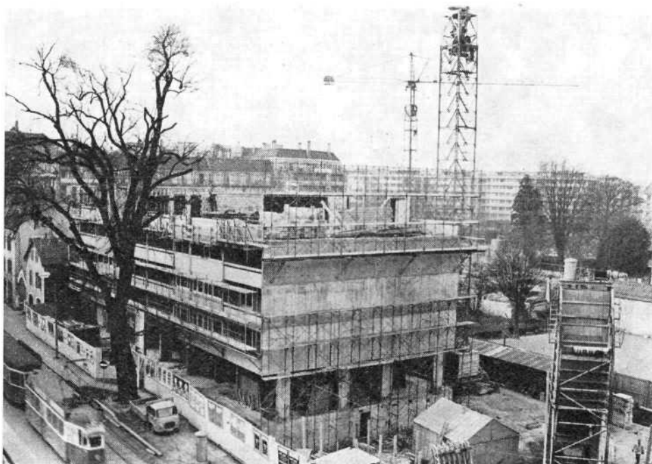
Chantier du groupe locatif des Minoteries (première étape — bâtiments à front de la rue de Carouge).
