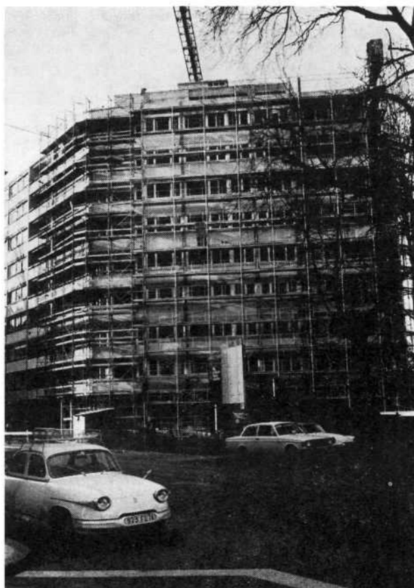
Construction de l'immeuble C, rue de Carouge, dans le lotissement des Minoteries.
