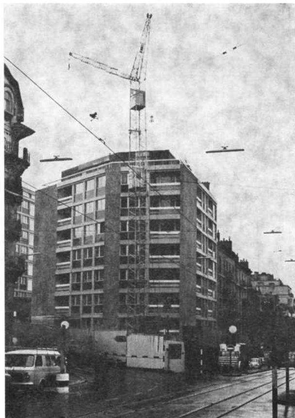
Construction de l'immeuble locatif rue de la Terrassière - angle rue de Villereuse.
