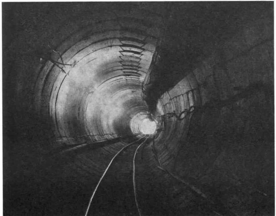
Galerie rive droite, tronçon Saint-Jean - Nations.
