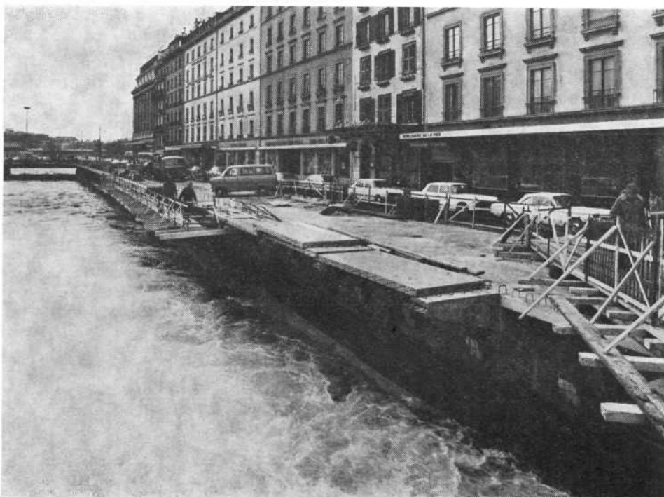
Reconstruction du quai des Bergues.
