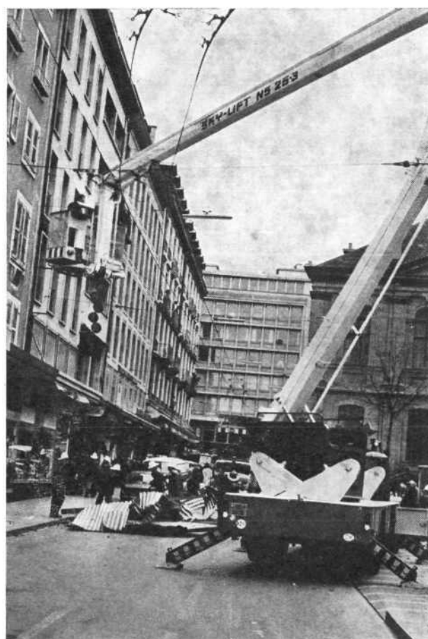
Travaux de déblaiement à l'aide de la nacelle hydraulique (25 avril, place de la Fusterie : toiture tombée sur les lignes de trolleybus, arrachée lors de l'ouragan).
